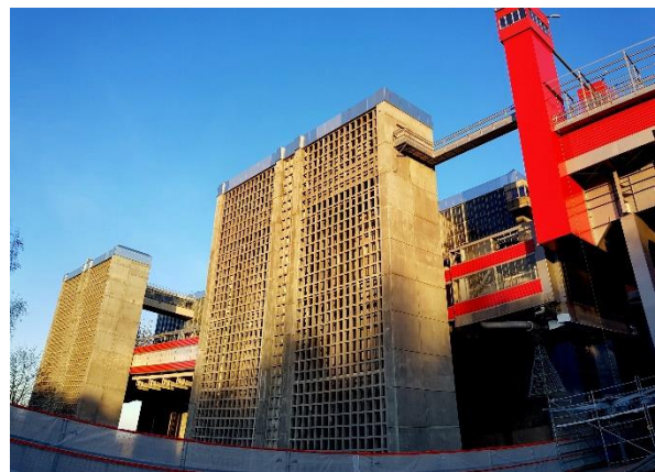
Seitenansicht des Schiffshebewerkes
