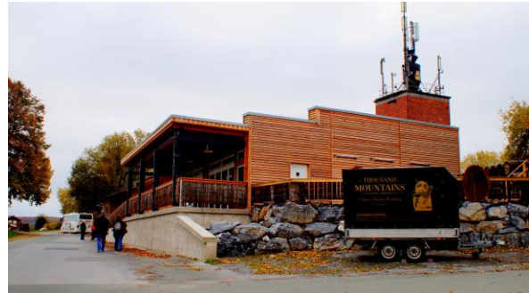
Außenansicht der Edelbrennerei
