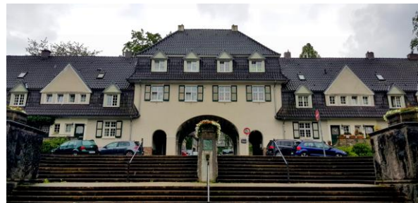
Eingang zur Margarethenhöhe am Brückenkopf
