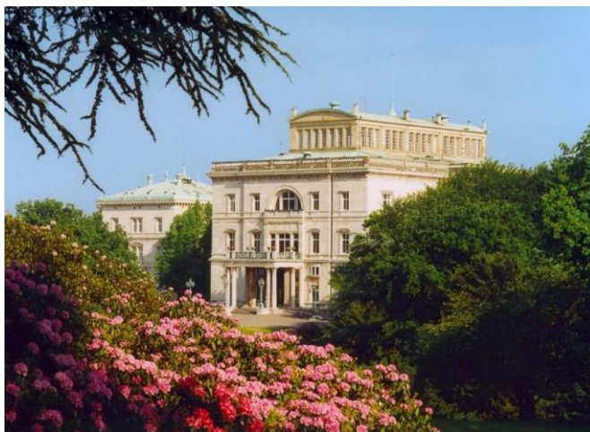
Blick auf das Hauptgebäude vom Garten
