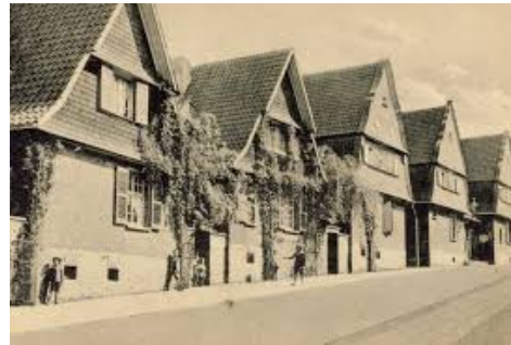
Historische Ansicht der „Steilen Straße“
