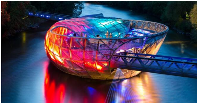
Mursinsel – Künstliche Schwimmende Plattform in der Mur
